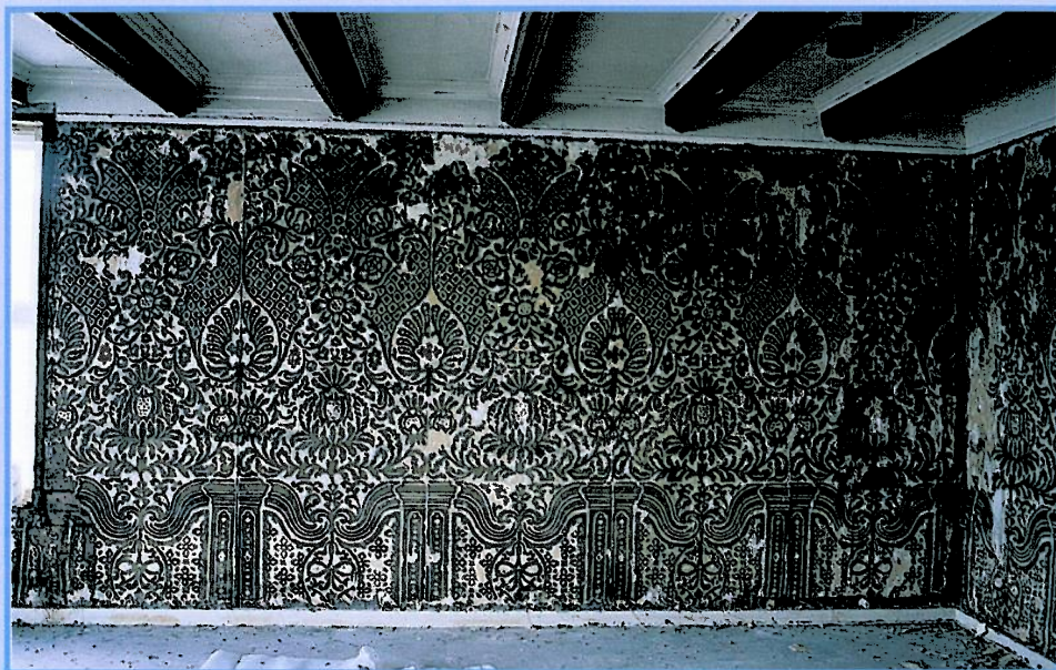
I Tollbugaten 54, Cappelengården i Drammen, ble det i 1997 funnet et meget sjeldent lerretstapet fra ca. 1700. Tapetet er muligens Norges eldste. Det er håndtrykket og illuderer ulldamask. Tapetet var dekket med flere lag veggpapp og yngre papirtapeter.
